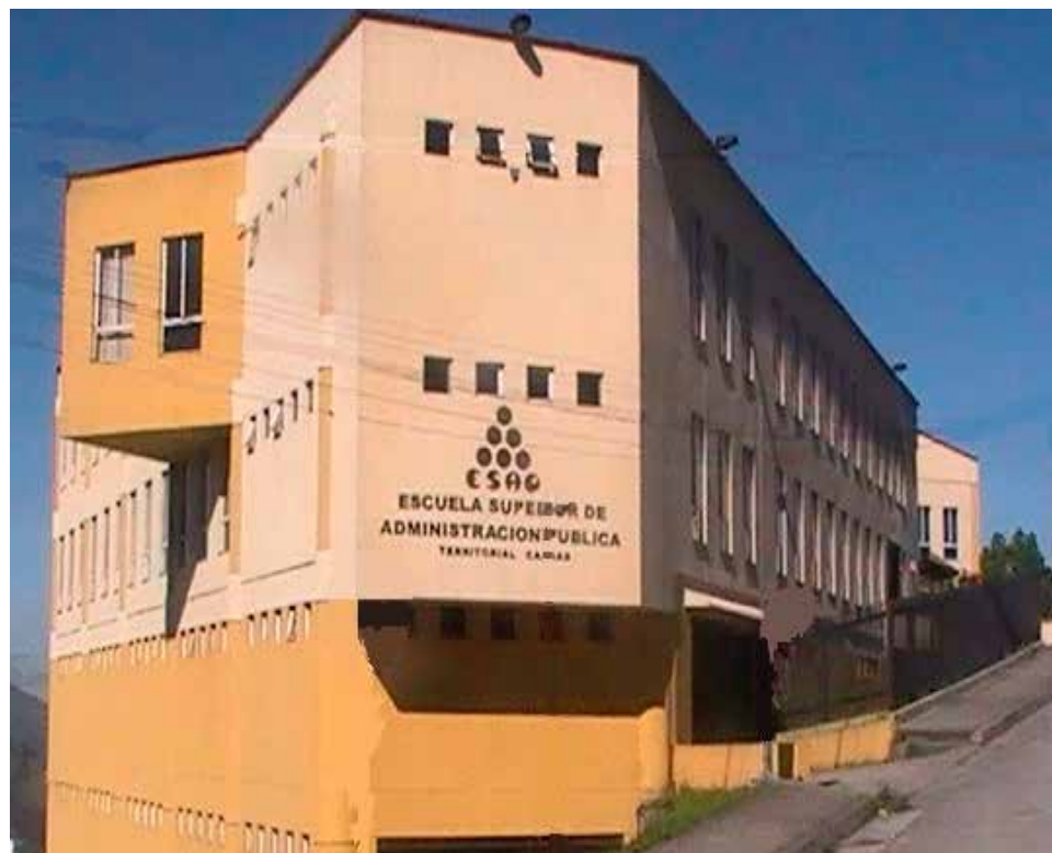
Sede de la ESAP en Caldas en la cual reciben formación de pregrado y posgrado los funcionarios del sector público. La edificación no sufrió daños severos tras del sismo. (Foto de la ESAP)
